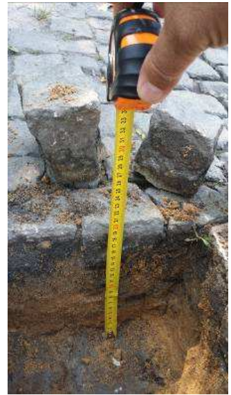
Fot. 3 Przekrój istniejącej nawierzchni
