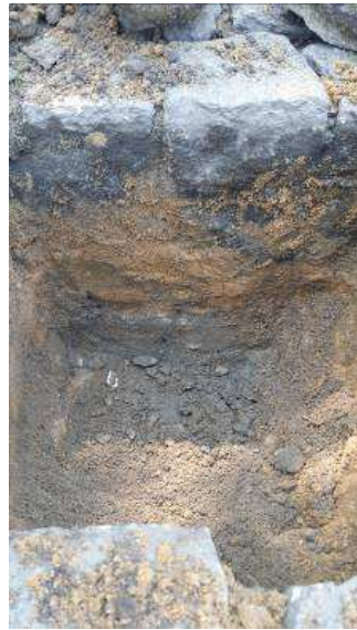
Fot. 3 Przekrój istniejącej nawierzchni
